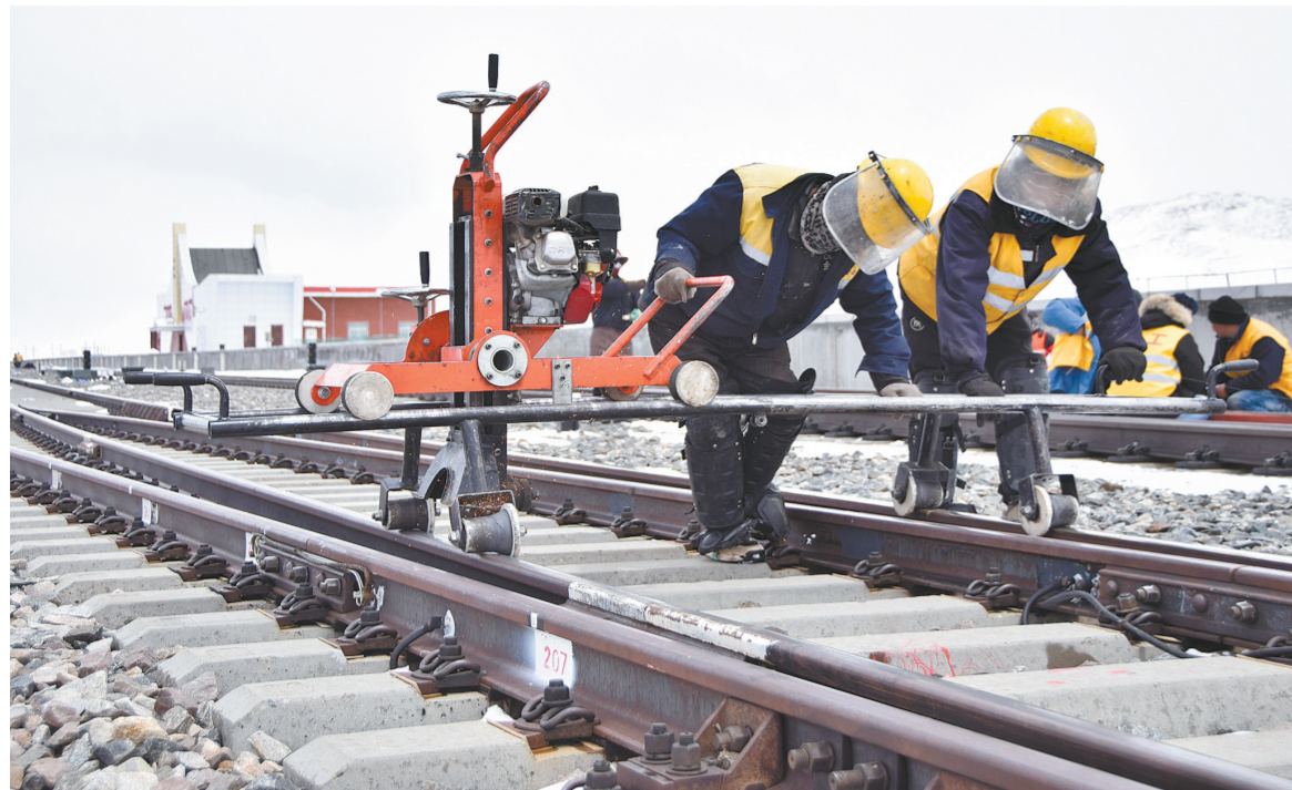
施工现场风雪交加。
