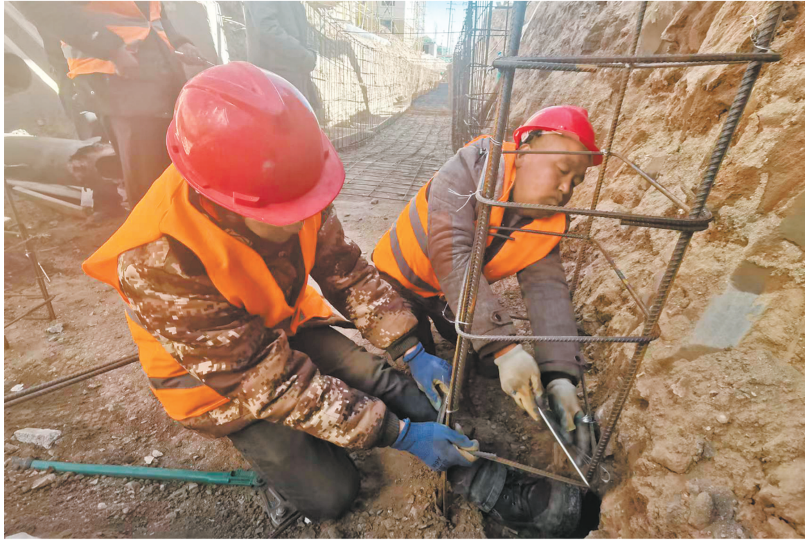
工人们正在架设暖气管道地下管廊混凝土支架。
