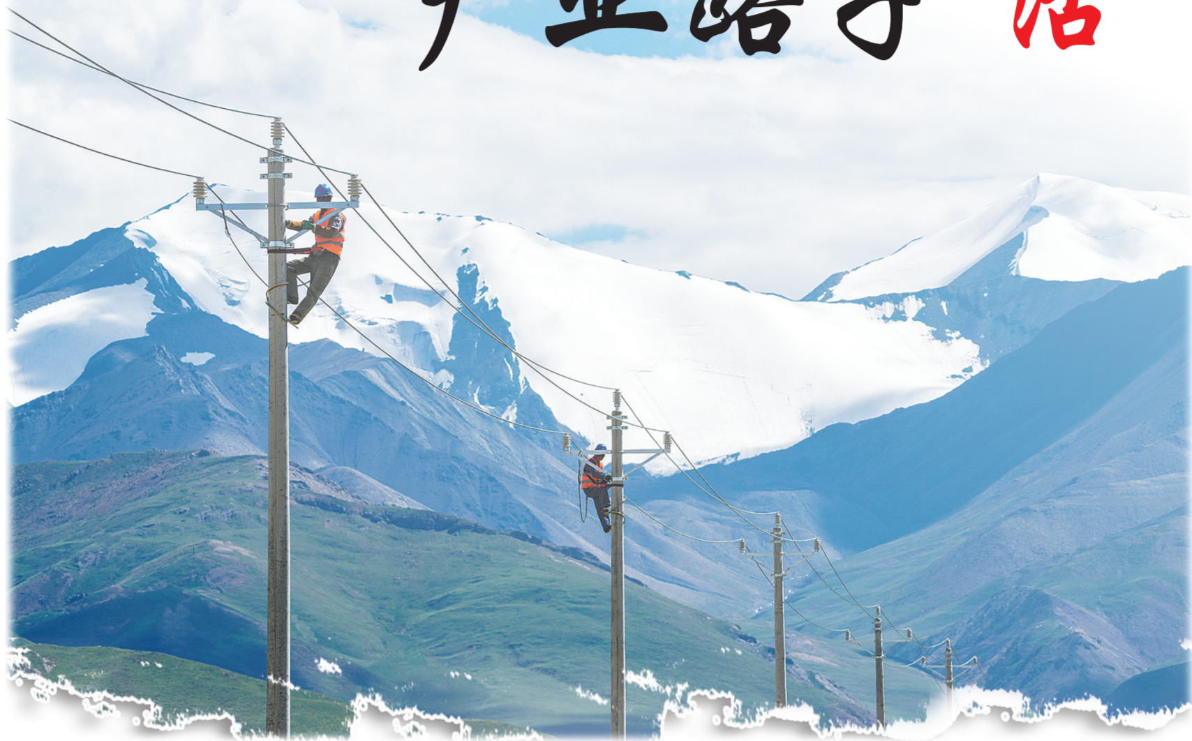
国网海北供电公司在海北州祁连县央隆乡改造10千伏隆2路配电网线路保障藏乡群众用电。
