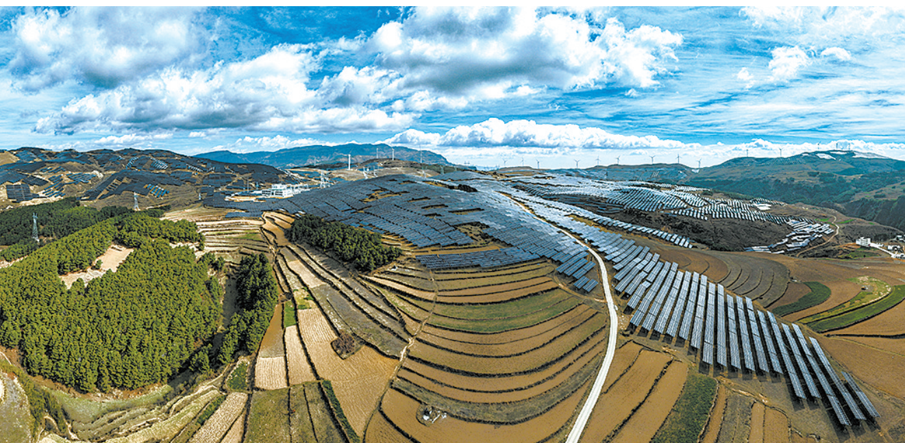
这是3月20日拍摄的云南省巧家县海坝光伏电站(无人机照片)。金沙江下游风光水储一体化国家示范基地位于金沙江下游干热河谷地段,主要依靠当地水电开发项目统筹建设风能、太阳能电站。目前,云南省巧家县海坝、小羊窝等光伏项目已投产发电。
