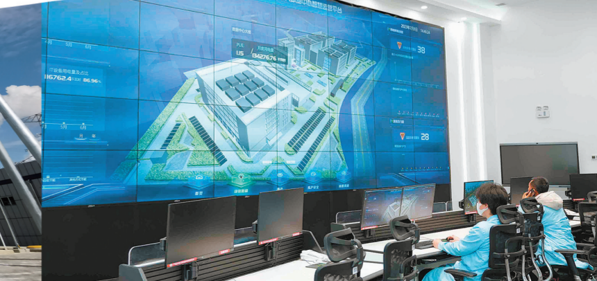
位于青海省海东市河湟新区的中国电信（国家）数字青海绿色大数据中心。
