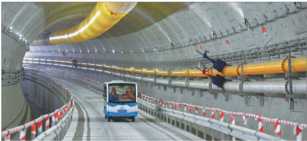
3月12日,中铁十四局的工人在长沙市湘雅路过江通道右线隧道内巡查。当日,由长沙城发集团投资建设、中铁十四局集团承建的中铁十四局湘雅路过江通道右线隧道贯通,这意味着湖南省在建最大直径的盾构隧道实现双洞贯通。据悉,长沙市湘雅路过江通道工程的隧道设计为双向六车道,行车时速50公里,建成通车后将有效缓解过江通行压力。
