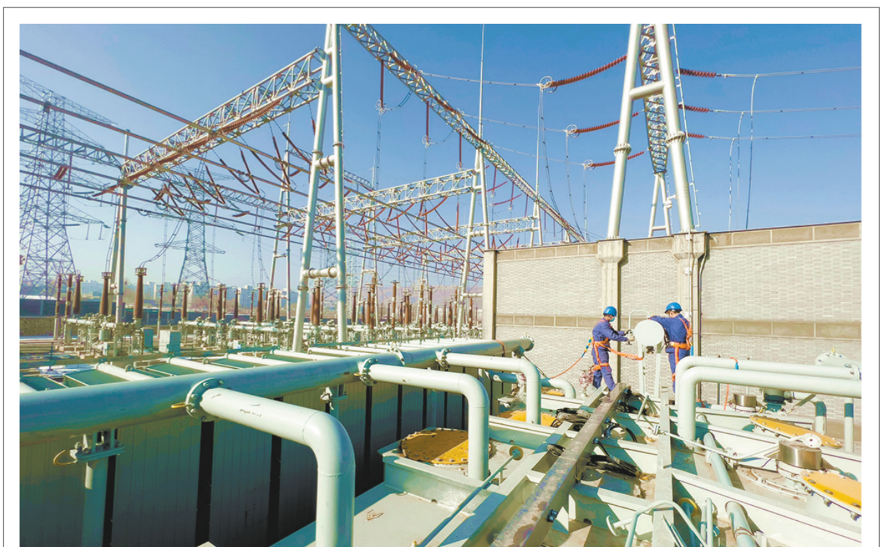
近日,记者在西宁市南川工业园区的330千伏麻岭变电站主变扩建现场,看到国网青海电力施工人员正在对4号主变压器进行附件安装。该扩建工程投运后,将进一步提高西宁市南川工业园区区域供电稳定水平,满足未来园区新增用电负荷需求,对优化园区电网结构,助力园区发展提供强有力的电力保障。本报记者 魏雅琪 通讯员 汪晓刚 摄
