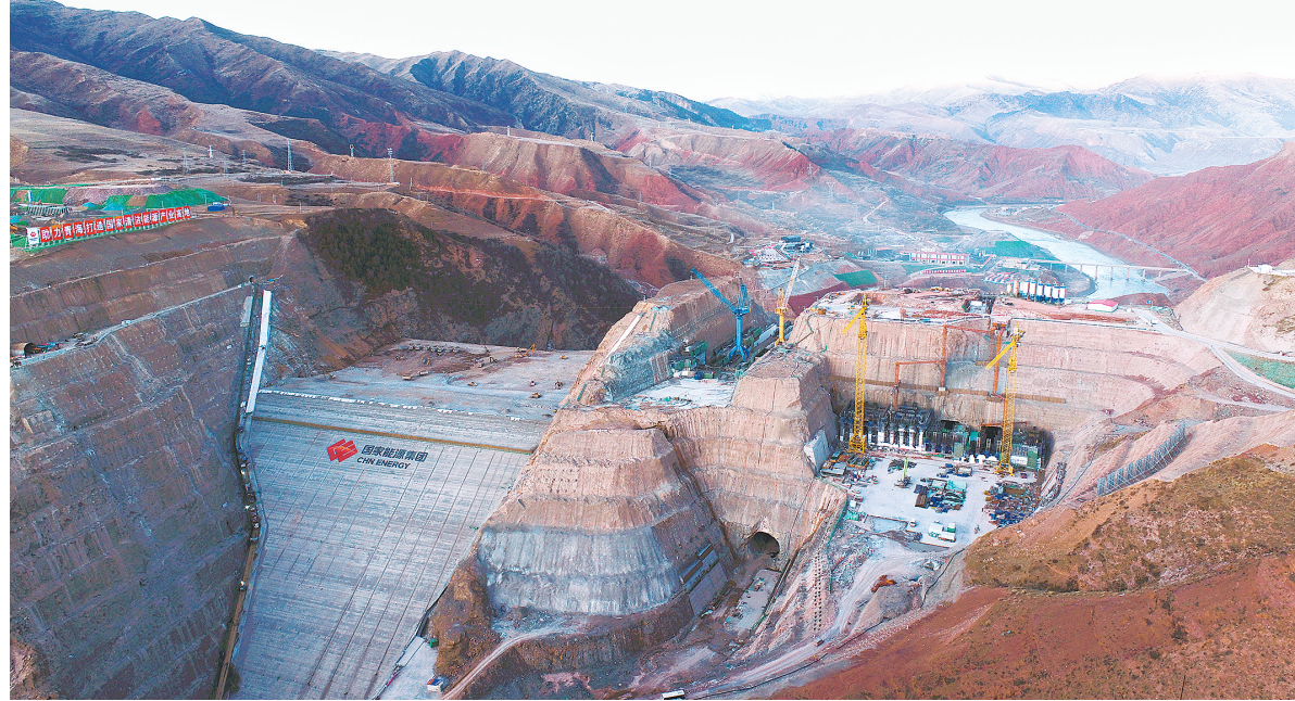
玛尔挡水电站施工现场。
