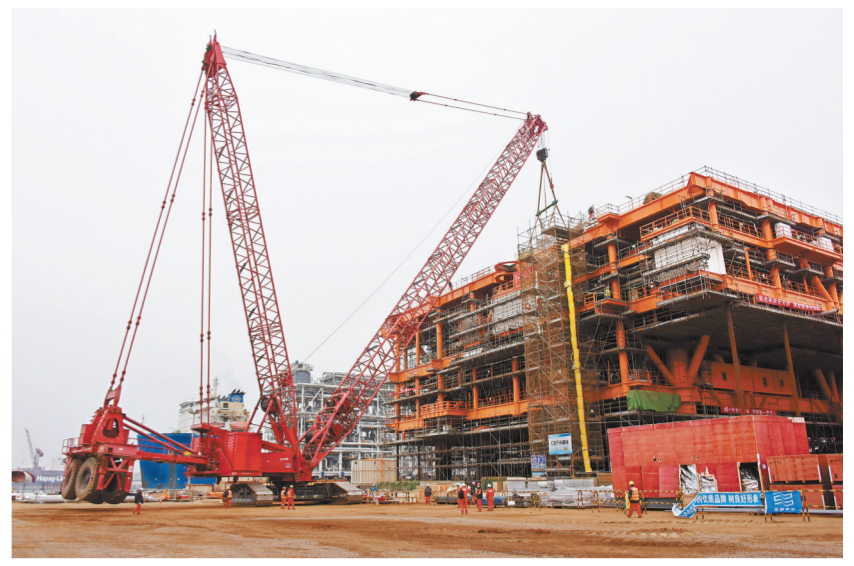
2月22日，渤中19-6凝析气田一期CEPA（中心处理平台）组块建造现场正在进行吊装作业。
