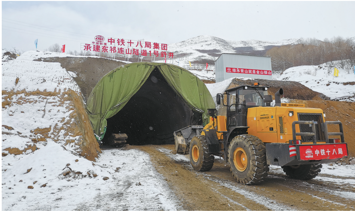
西成铁路东祁连山隧道1号斜井施工现场。
