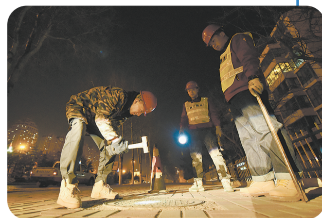
不畏严寒保供水
