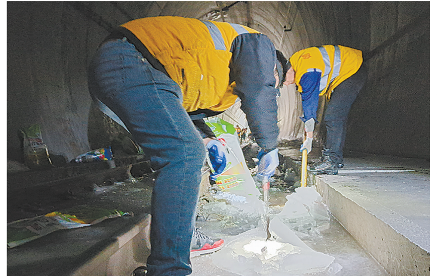
天棚桥隧养修工区的职工正在隧道内进行除冰工作。
