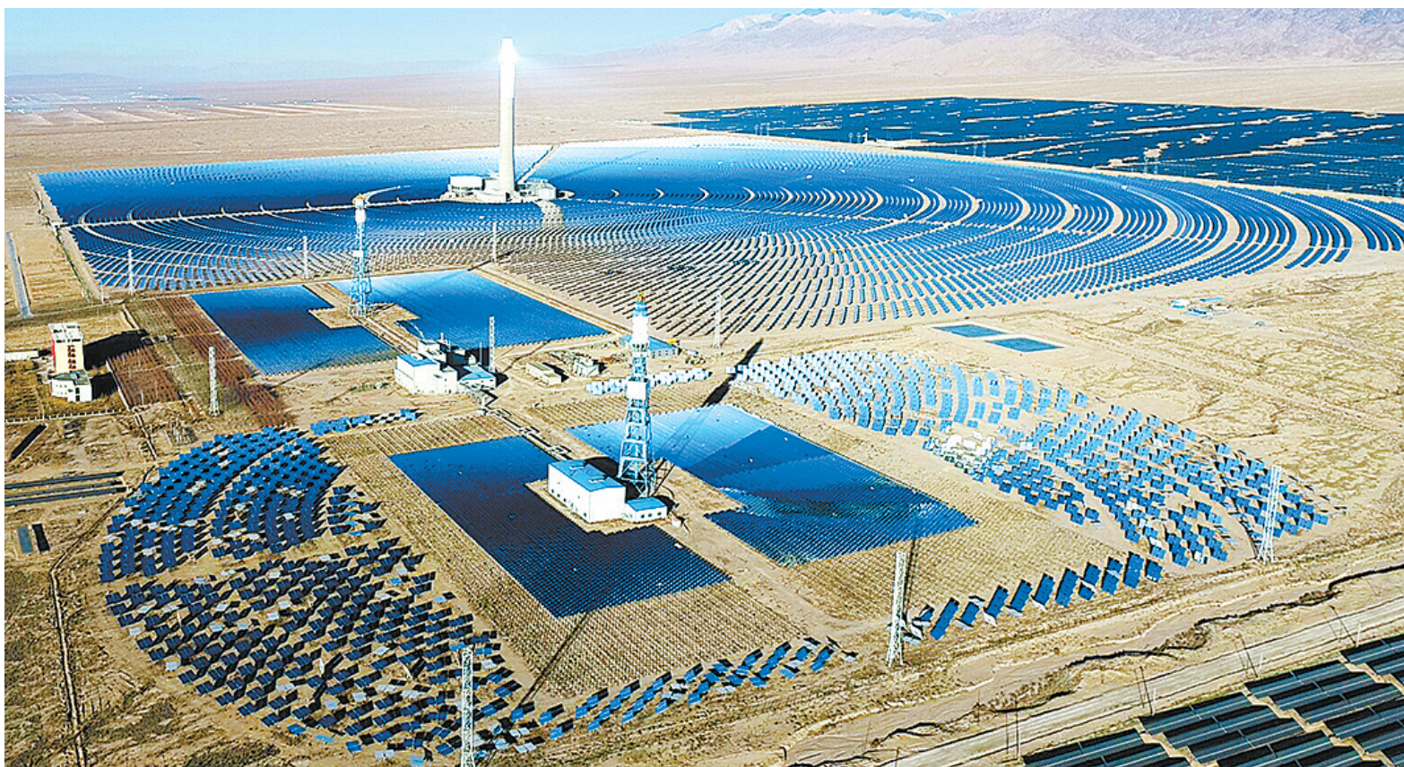
位于青海海西德令哈地区的光热发电厂。
