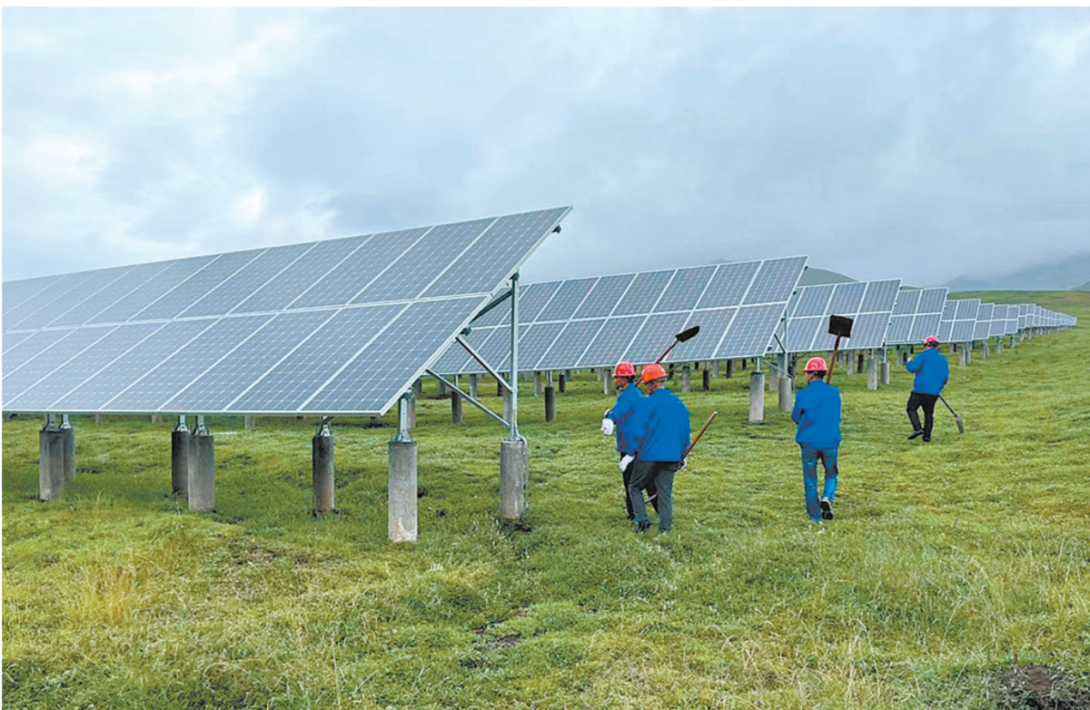
工作人员清除光伏板附近的杂草。
