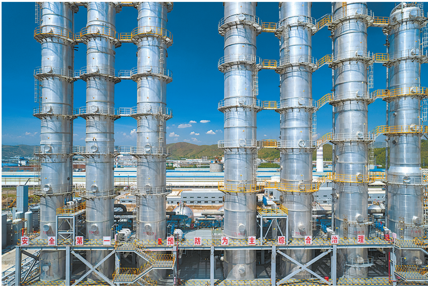
亚洲硅业(青海)股份有限公司的提纯装置,热耦合精馏塔。
