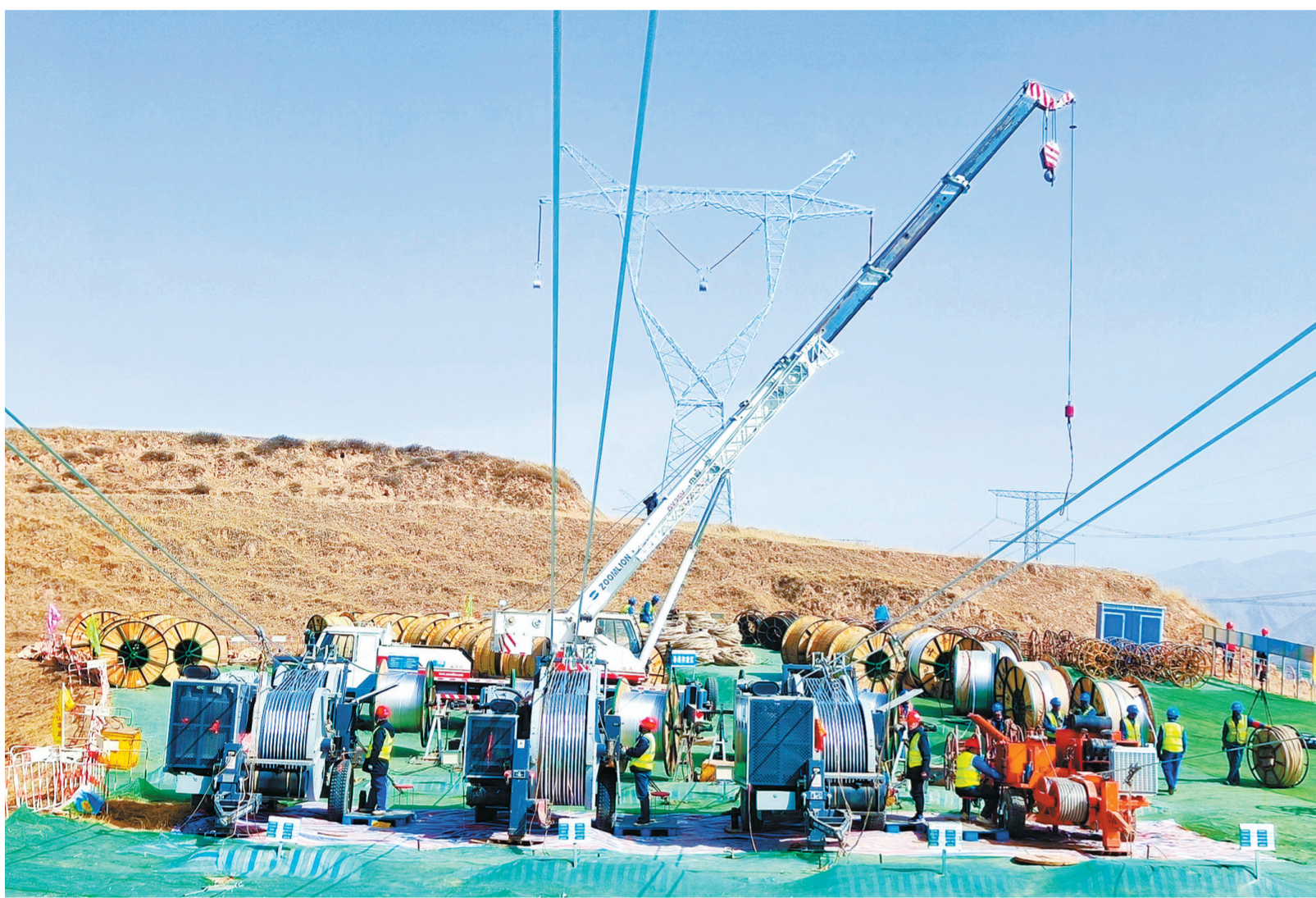
郭隆-武胜第三回750千伏输电线路工程(青海段)首场架线施工现场。
