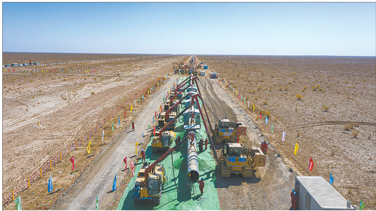
西气东输四线工程全面开工
