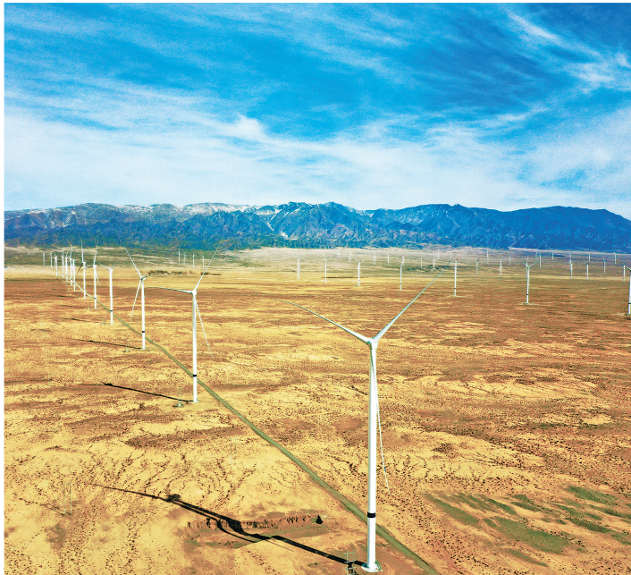
青豫直流一期配套电源风电项目。
