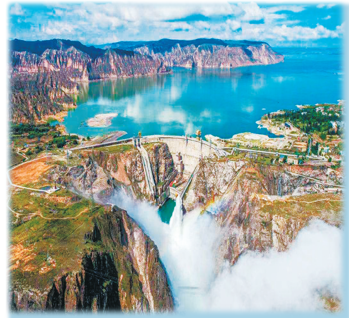
龙羊峡水电站。
