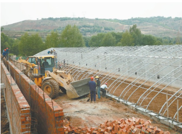
麻地沟村食用菌基地二期扩建工程。
