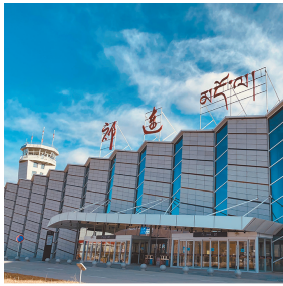
建成投运的祁连机场。 青海机场有限公司供图
