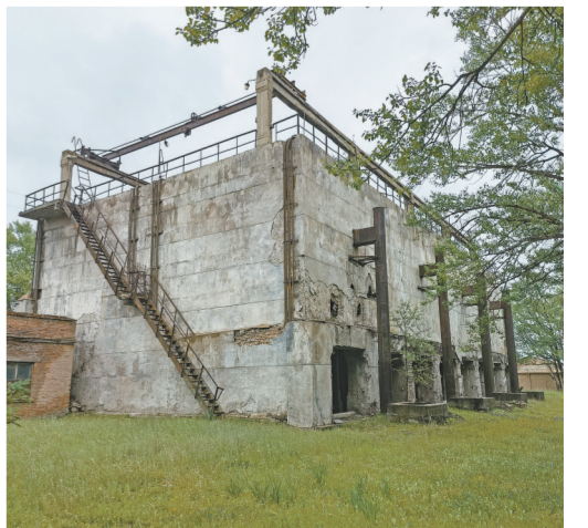
二二一厂四分厂冷却塔遗址。 潘玲 摄
