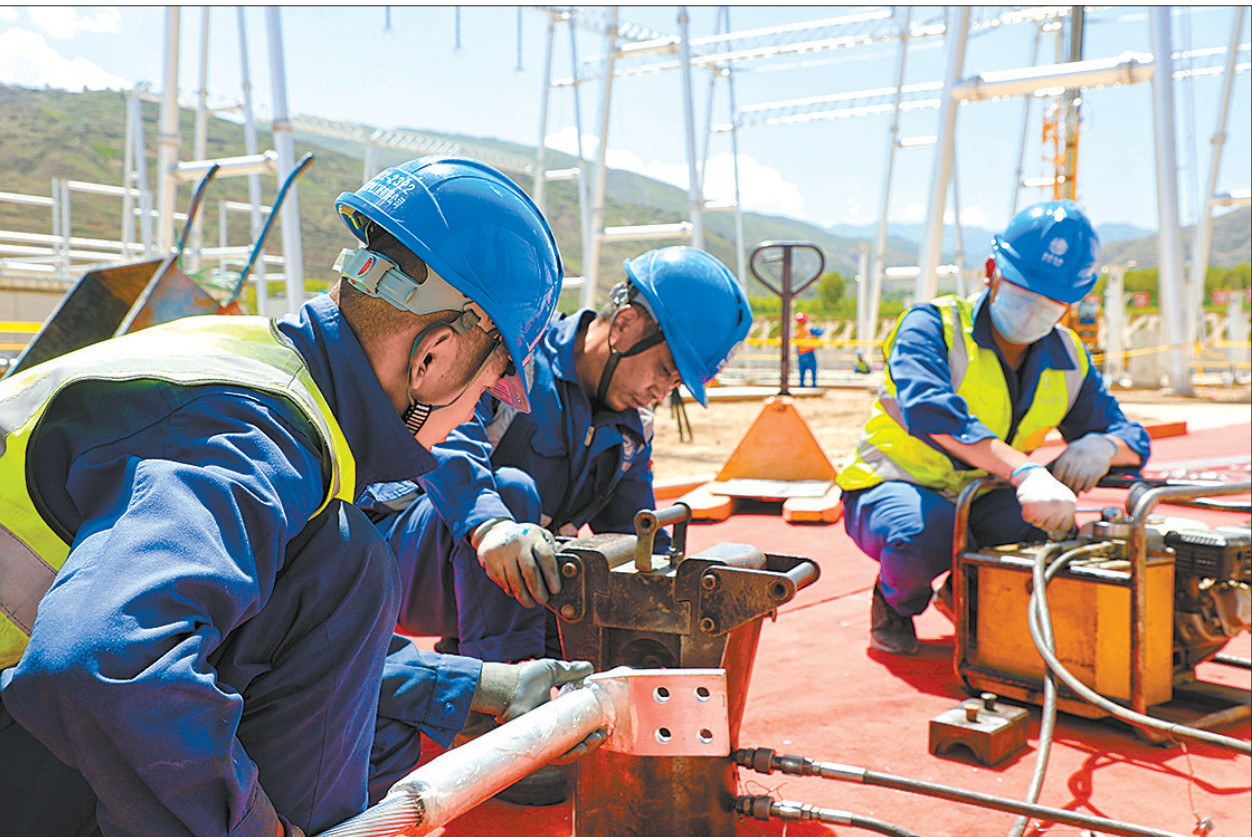
7月8日，青海送变电工程有限公司电气施工人员在黄南藏族自治州同仁330千伏变电站新建工程现场进行软母线压接和安装工作。该工程建成投运后将满足黄南藏族自治州负荷供电需求，缩短省内330千伏变电站供电半径，提高区域供电能力。
