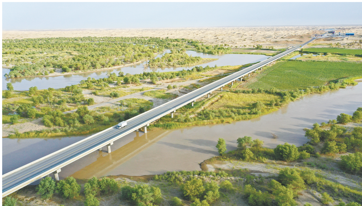
尉犁至且末沙漠公路穿越塔里木河和胡杨林(6月22日摄，无人机照片)。6月30日，尉犁至且末沙漠公路正式通车，成为我国建成的第三条穿越“死亡之海”塔克拉玛干沙漠的交通要道。尉犁至且末沙漠公路位于新疆巴音郭楞蒙古自治州(简称“巴州”)境内、塔克拉玛干沙漠东部腹地，全长334公里，是目前世界上流动沙丘分布最广、施工条件最恶劣、施工难度最大的沙漠公路之一。这条沙漠公路于2017年10月开工。建设者克服沙漠地区高温、缺水、风沙、沙尘暴多发等实际困难，攻克一系列沙漠筑路技术难题，同步推进环境保护、风沙防护与公路建设——保护湿地、胡杨林等稀缺原始生态的同时，沿线采取“草方格+阻沙障”的方式，用芦苇、尼龙网建立起立体化、多层次阻沙体系，降低风沙对公路威胁，延长公路运行寿命。
