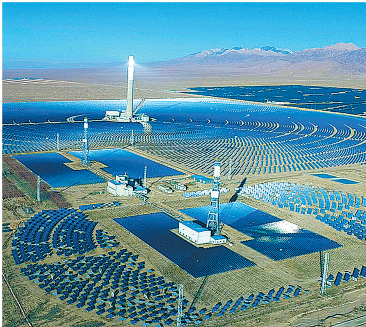
位于青海省海西蒙古族藏族自治州德令哈市清洁能源产业基地的光热发电站。
