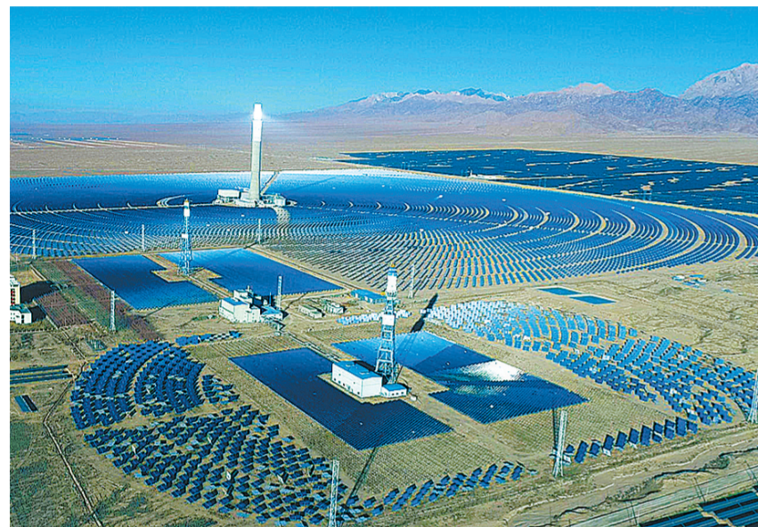
德令哈市清洁能源产业基地的光热发电站。
