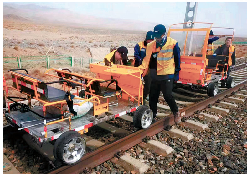
正在开展钢轨探伤工作。
