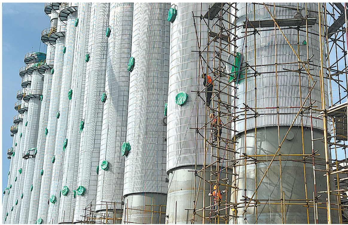
青海高景太阳能科技有限公司施工现场。
