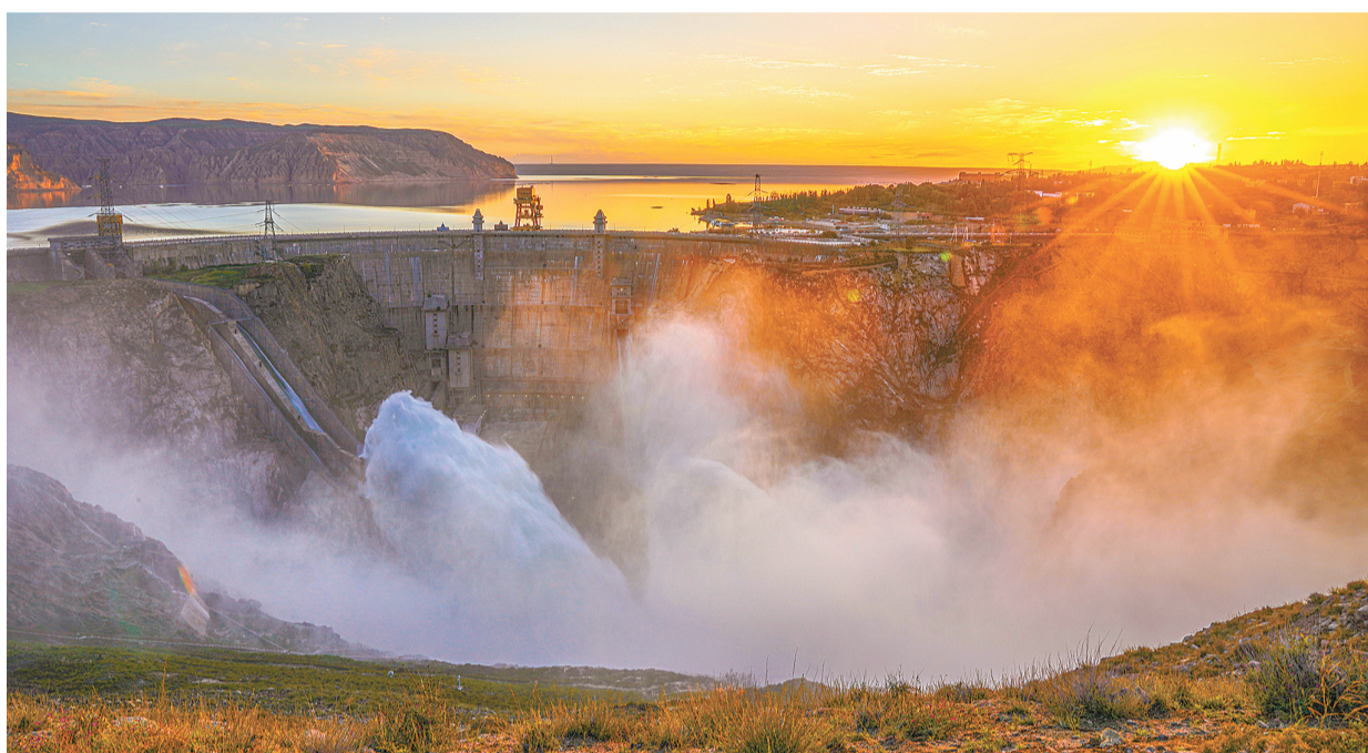
龙羊峡水电站。
