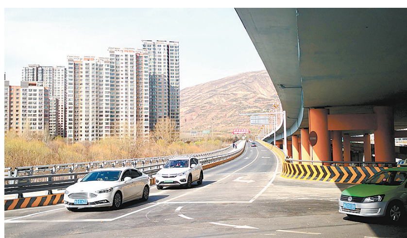
七一路西延、同仁路北延项目之西半幅桥梁实现通车后,有效地缓解了祁连路至同仁路高架桥车辆拥堵状况,对分流南北过境车辆起到了重要作用。目前东半幅正在加紧施工中。图为车辆行驶在西宁市同仁路北延西半幅桥上。
