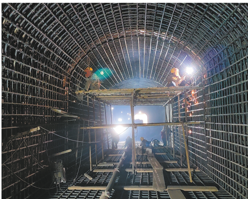
溢洪道隧洞段钢筋制安。
