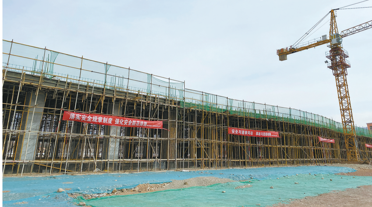
在建的循化县文体中心项目。
