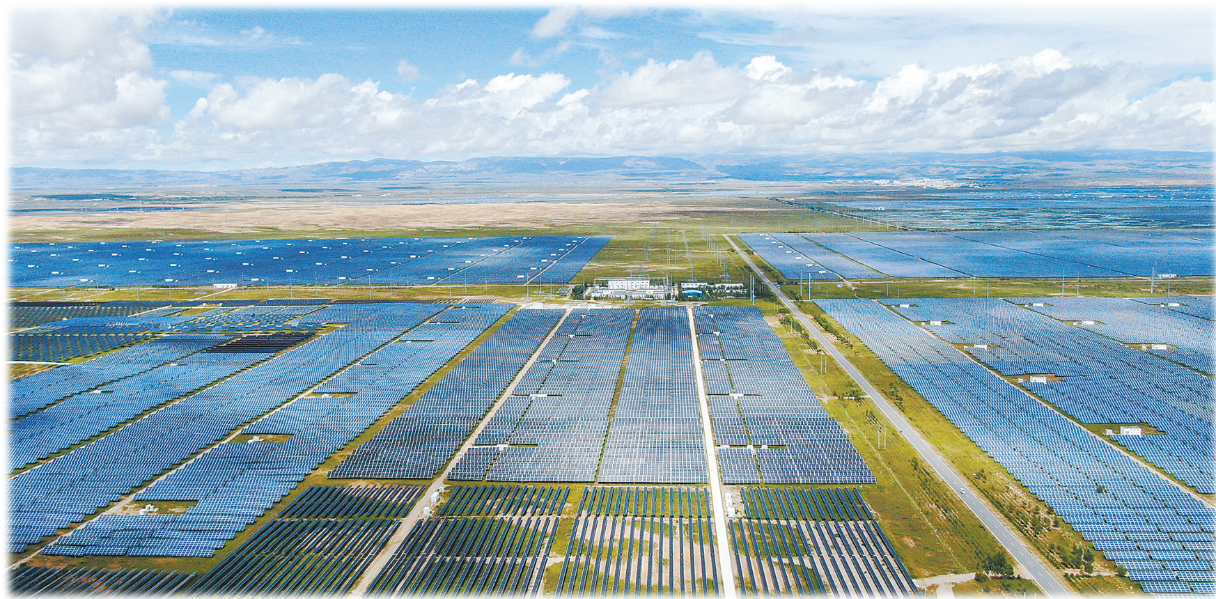
这是在青海省海南藏族自治州共和县塔拉滩绿色产业发展园区拍摄的光伏电站(2020年8月17日摄,无人机照片)。
