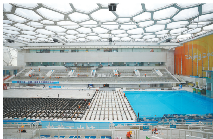
这是2019年7月10日拍摄的在进行冰场可转换结构施工的“冰立方”。
