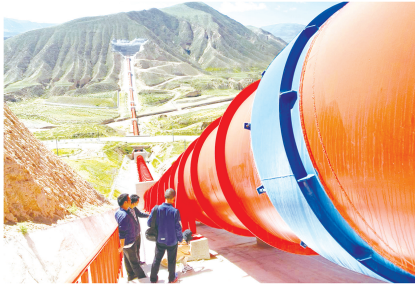
拉西瓦灌溉工程倒虹吸
