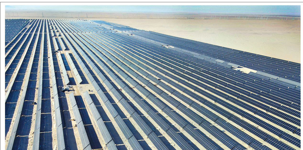
1月1日,记者来到位于海西蒙古族藏族自治州格尔木市青海港青鸟图美仁50MW平价光伏项目现场,一排排整齐的深蓝色光伏组件阵列将太阳能转化成为电能,并送往千家万户。该项目由青海格尔木港青新能源科技有限公司开发建设,于2021年12月30日成功并网发电,项目总投资2亿元,装机规模50MW。项目投产后,年平均发电量为1950等效利用小时。图为青海港青鸟图美仁50MW平价光伏项目,连绵的太阳能光伏板组成“蔚蓝海洋”。 本报记者 苏烽 马振东 摄
