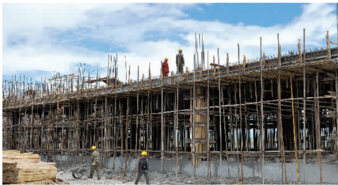
在玉树藏族自治州治多县境内,记者看到,治多县汽车站建设现场施工工人正在加紧施工。2014年上半年以来,我省各地区积极按照省委、省政府确定的战略部署,重点加强民生工程、基础设施、灾后重建等领域的重大项目、重点工程建设。
