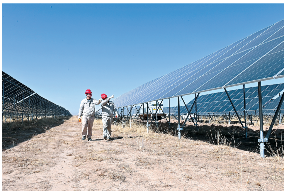
运维员在光伏项目现场进行定期巡检工作。
