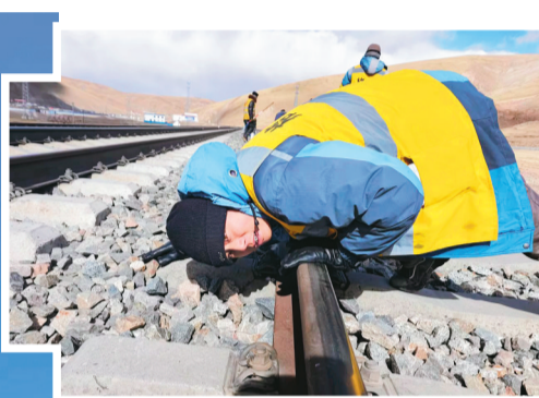
工人对铁路线路设备进行整修。
