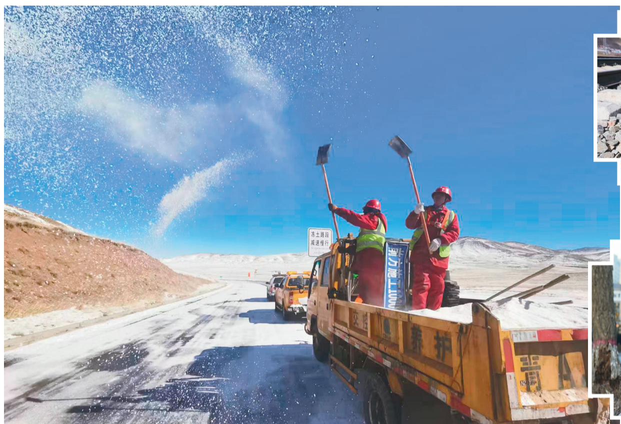
在西丽高速玛多查拉坪段,路政工作人员,正在向结冰路面撒布融雪剂。
