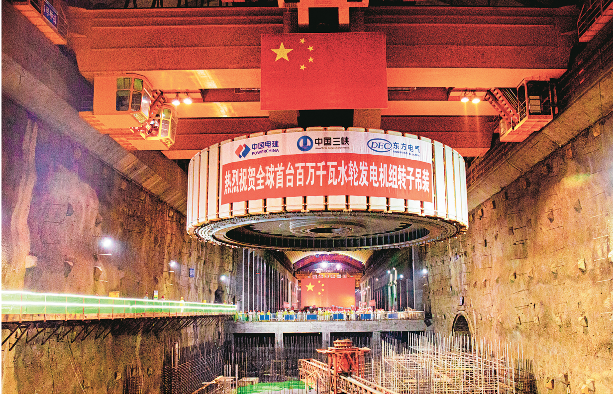
白鹤滩机组吊装现场。
