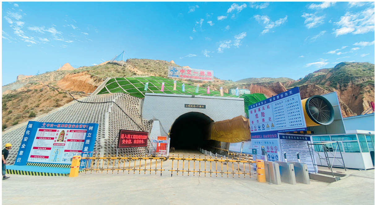
西成铁路建设现场。
