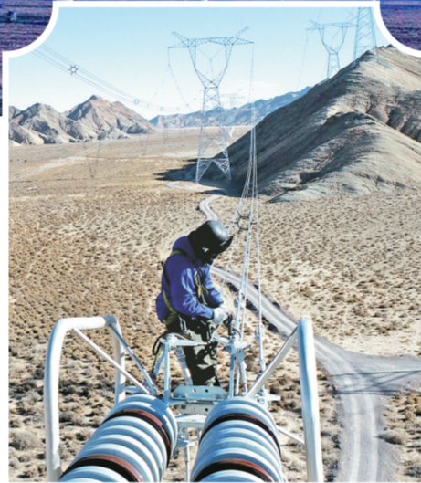
青海特高压工程施工现场。 王国栋 摄
