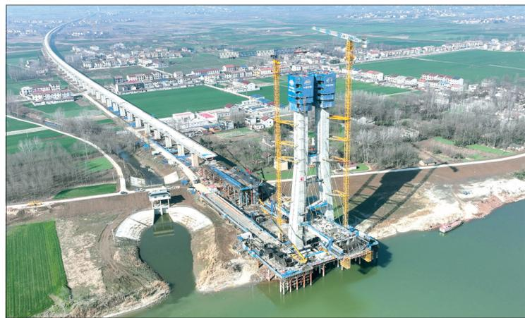
1月24日拍摄的正在进行的顶梁混凝土浇筑作业的主塔(无人机照片)。当日，由中铁十一局集团承建的沪渝蓉高铁武宜段钟祥汉江特大桥317号主塔顺利封顶。沪渝蓉高铁是我国“八纵八横”高铁网沿江高铁通道的重要组成部分。其中，武汉至宜昌段正线全长313公里。钟祥汉江特大桥横跨汉江，是沪渝蓉高铁武宜段的关键控制性工程。
