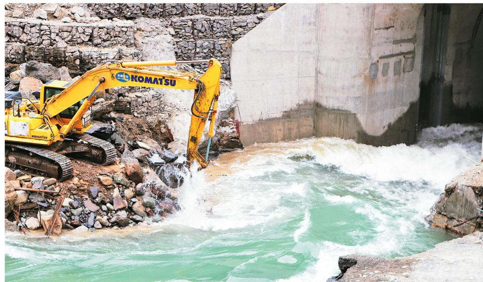
1月3日，一台挖掘机在大唐扎拉水电站项目导流洞入口处施工。
