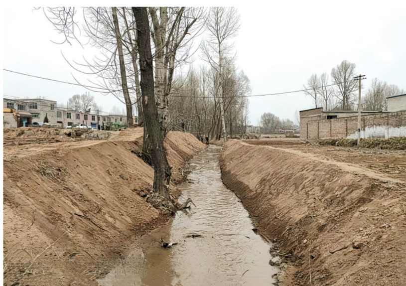
整改完毕后的河道。
