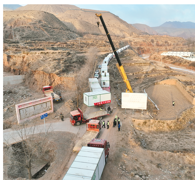
建设者们正在安装活动板房。
