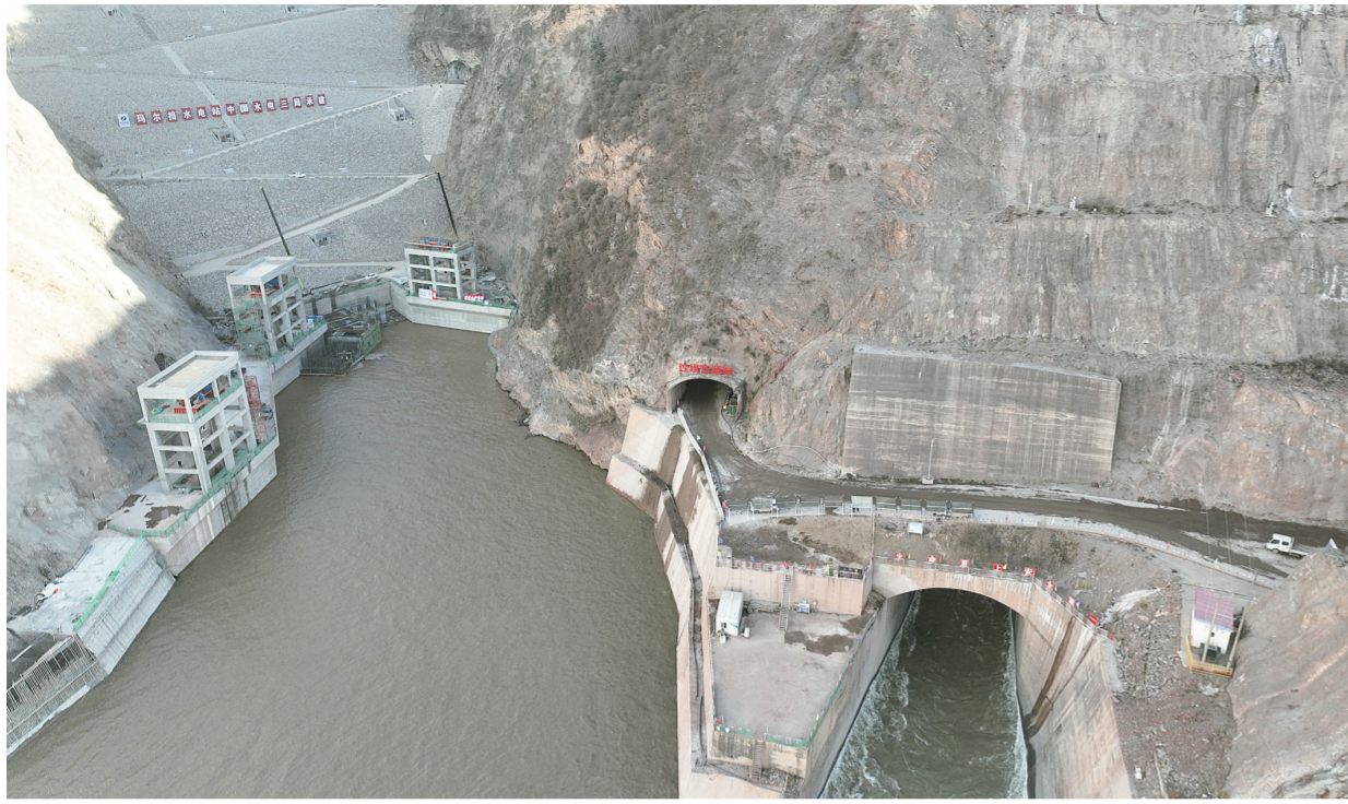
玛尔挡水电站正式下闸蓄水。
