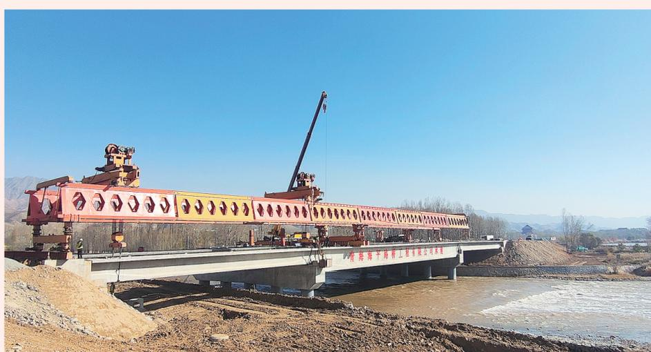
11月9日,总投资3100万元、由青海海平路桥建设者历时6个月奋战,省内首座简支T型梁桥跨度和高度最大的公路桥梁康康大桥顺利合龙。该桥主跨50米预应力简支T型梁,梁板高度3.2米,最大起重量210吨,是海东富源产业园内金辉大道的重要组成部分,建成后不仅可助推国际生态旅游目的地打造、促进海东富源产业发展、带动河湟·平安驿旅游,而且对拓展发展空间、提升区域综合运输能力、改善投资环境等具有一定意义。
