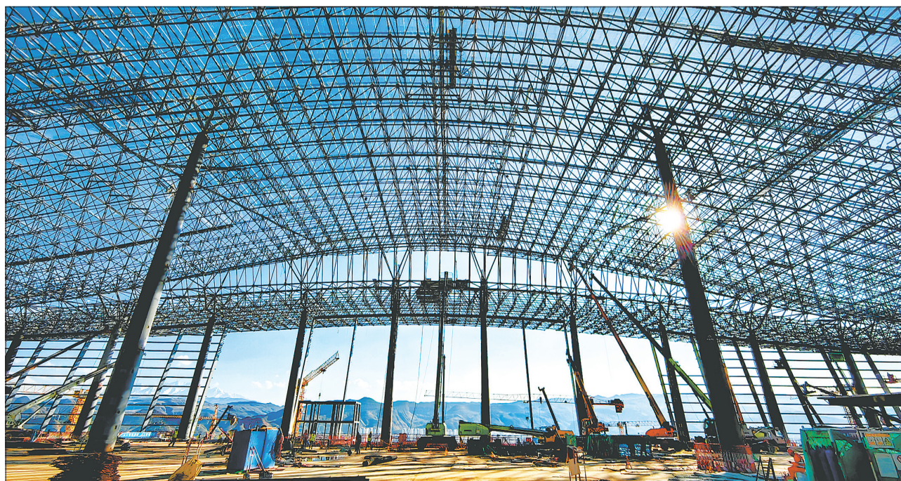
作为青海民航“头号”工程和我省深度融入“一带一路”建设的重点工程,西宁机场三期扩建工程新建T3航站楼目前正在加紧建设,钢结构工程已全面封顶,屋面、幕墙和室内装饰装修及机场道路等设施正在加紧施工,计划2025年建成投运(10月21日摄)。本报记者 祁国彪 摄
