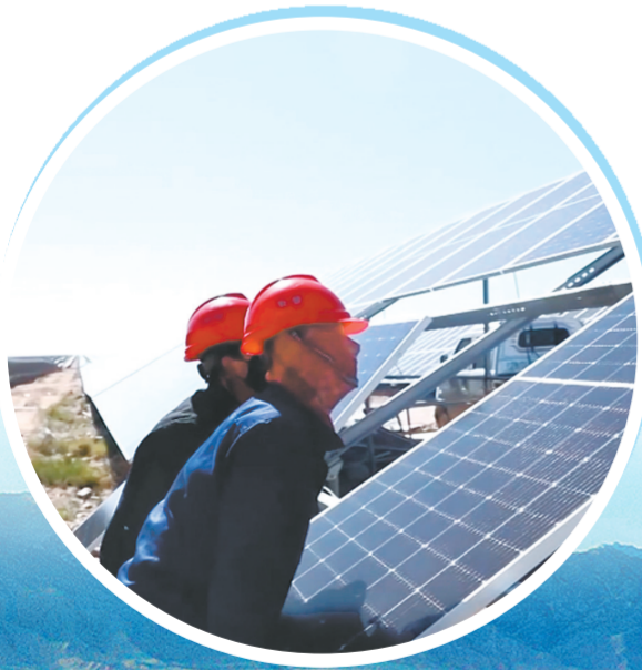
工人架设太阳能光伏发电板。
