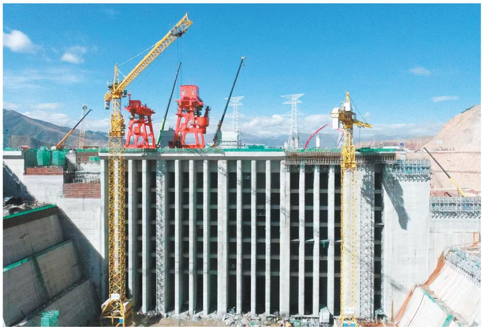
10月11日上午,随着最后一仓混凝土倾泻而下,玛尔挡水电站大坝所设计建造的5座进水塔,全部完成封顶作业任务,标志着大坝建设项目中进水口主体工程全部完工。下一步将集中力量进行坝前铺盖填筑等收尾工作,迎接10月底进行的蓄水。玛尔挡水电站大坝进水塔依次布置有拦污栅、叠梁门、检修闸门、快速闸门等五个模块,是为发电机组提供水能,确保水电站能够生产电能的关键设施之一,是水电站的核心和重点控制性工程。据了解,5座进水塔高度达63米,相当于21层住宅楼高。混凝土总浇筑量达到了20余万立方米,钢筋用量超8700吨。施工人员从2022年5月14日进水塔主体首仓混凝土浇筑至今,仅用了1年零5个月的时间,提前完成了建设任务,为玛尔挡水电站能在2024年3月实现首台机组投产发电奠定了坚实基础。
